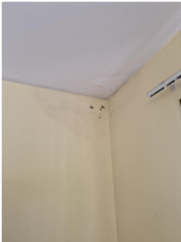
Foto 33. Vista da parede com infiltração.
