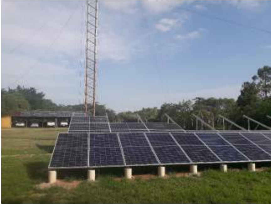
Figura 2: Placas fotovoltaicas em processo de instalação na UC ESEC Guanabara
