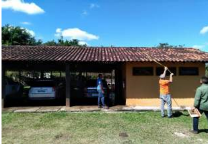
Figura 4: Área sobre o telhado, onde inicialmente seriam colocadas as placas.
